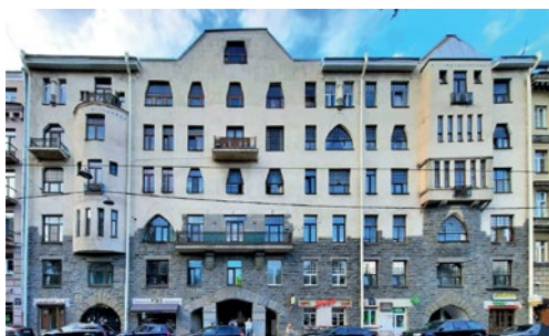
Дом № 23 по Кронверкскому проспекту. 2022.
